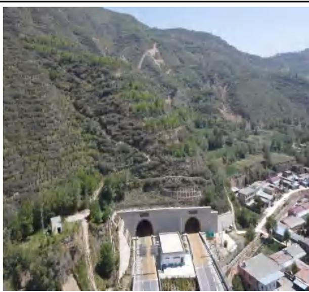
老营庄隧道出口仰面工程植物护坡排水
